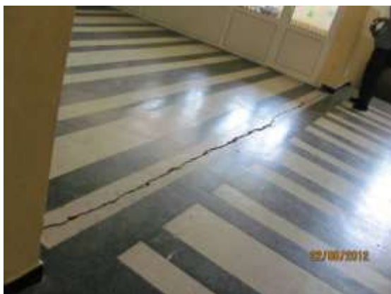
Фиг.10: Напукана фуга между блок 2 и 3 – интериорен и фасаден вид
