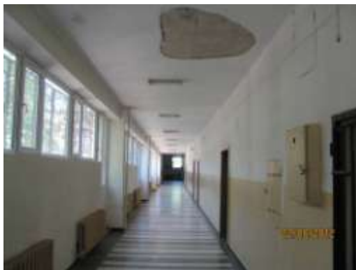
Фиг.2: Бл.2 – Общ вид на конструктивната система в коридора и учебните зали. Вижда се парче откъртена от земетръса мазилка от тавана
