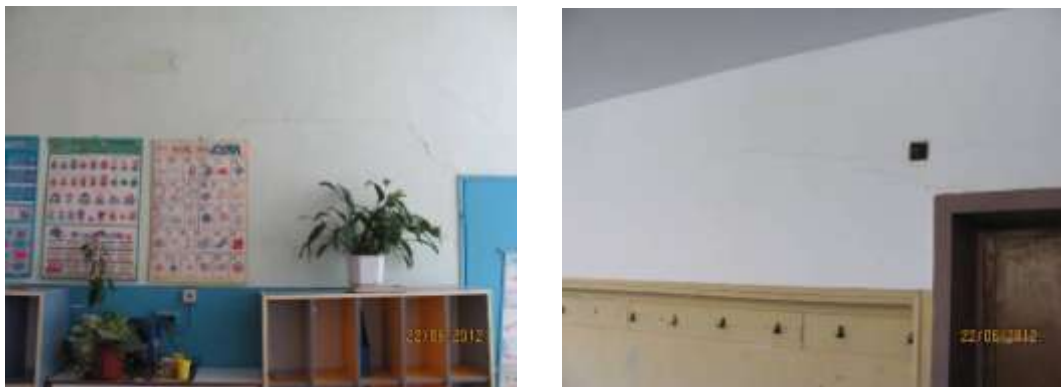
Фиг.4: Бл.1 – Стени в административната част, напукани от увеличени вертикални деформации на подовите конструкции.
