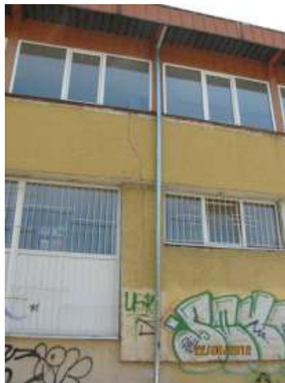
Фиг.10: Напукана фуга между блок 2 и 3 – интериорен и фасаден вид
