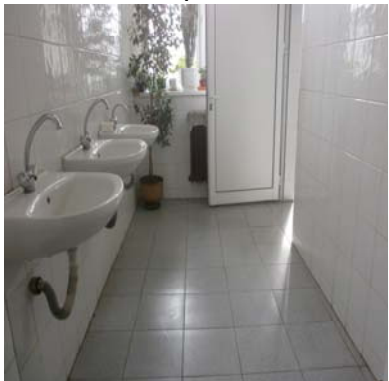
Ремонтиран санитарен възел
