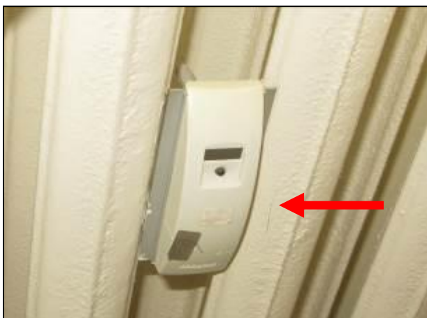
Фиг.1.26 Чугунен радиатор с уред за дялово отчитане
