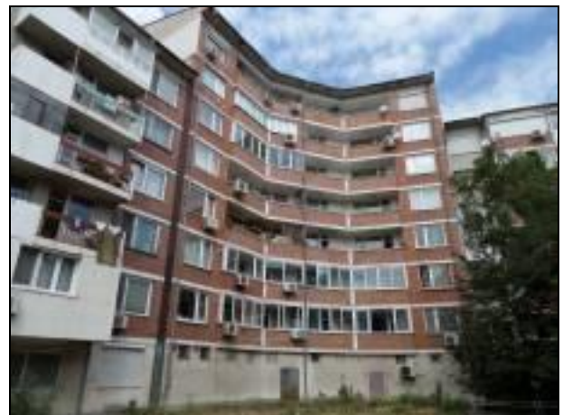
Фиг.1.3 Югоизточна фасада
