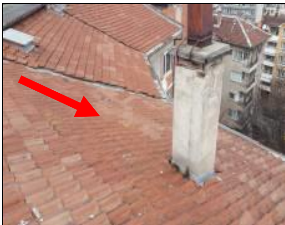
фиг.1.14 Скатен студен покрив
