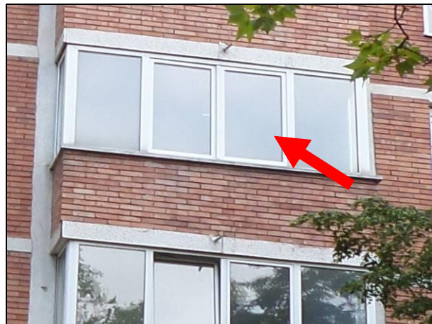
фиг. 1.13 Северозападна фасада
