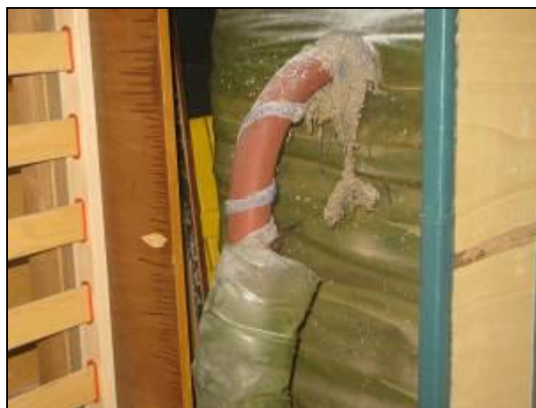
Фиг. 1.23 Отворен разширителен съд
