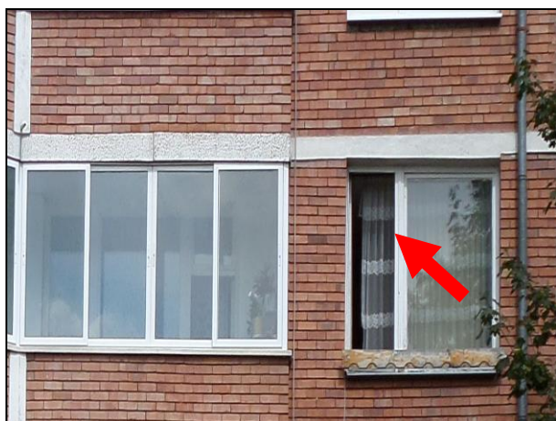
фиг.1.10 Югоизточна фасада
