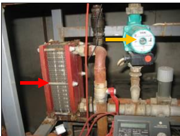
Фиг.1.29 Топлообменник с ЦП за БГВ
