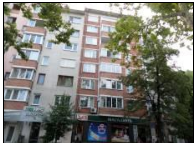
Фиг.1.5 Северозападна фасада
