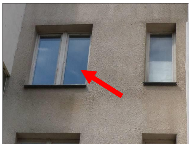
фиг. 1.11 Източна фасада
