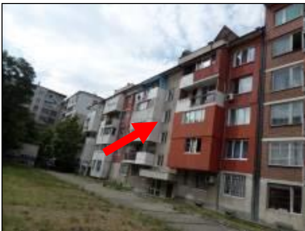
Фиг.1.2 Източна фасада
