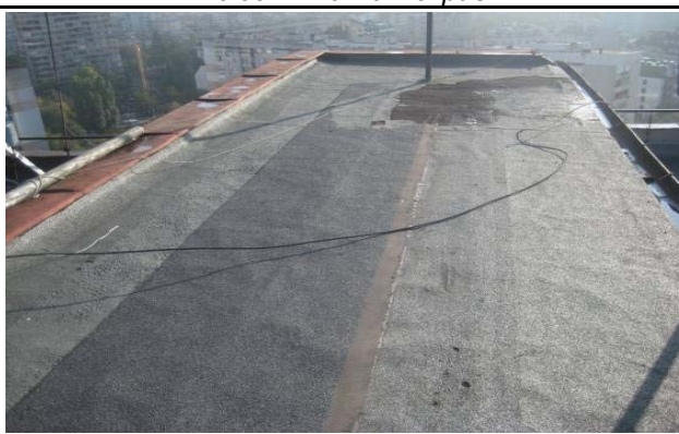
Плосък топли покрив
